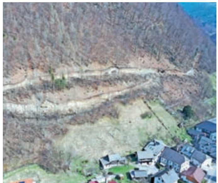
Sanacija brežine Na plavžu / Foto: Eho Projekt
